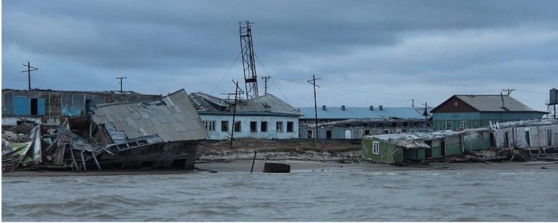
Рисунок 8.6: Зброшенные сооружения в д. Тадебя-Яха 382
